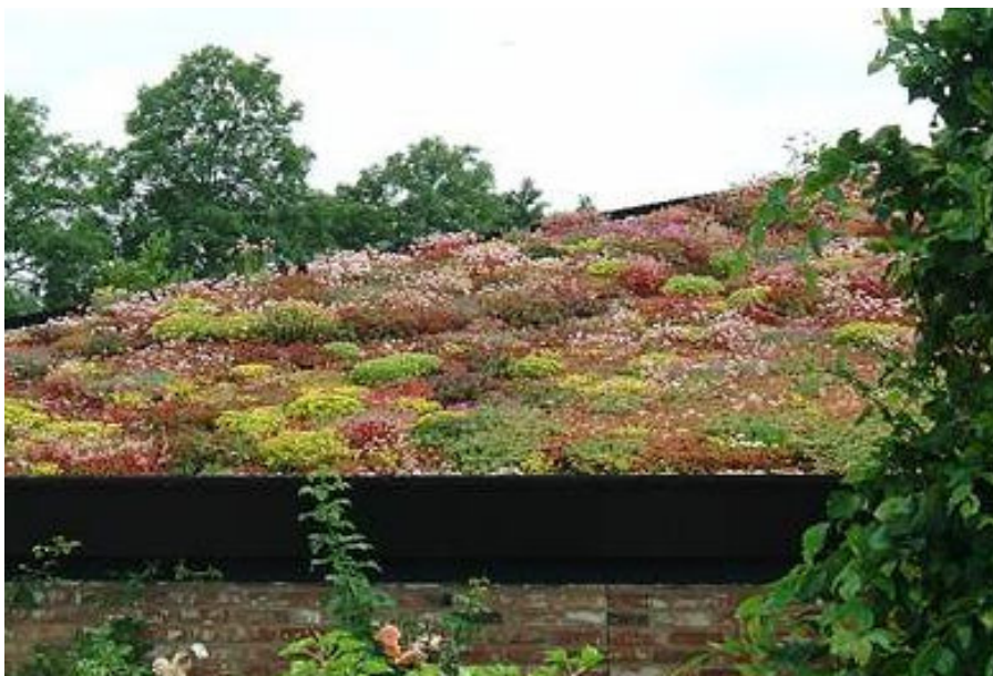
Foto 12. Voorbeeld van een sedumdak
